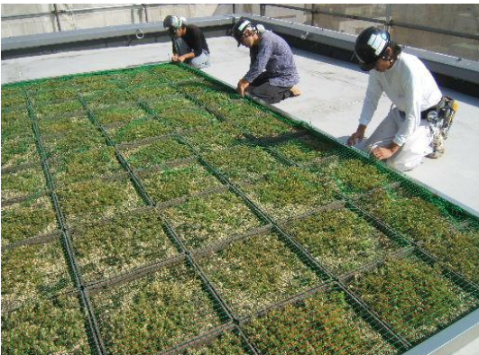
⑬ 防風ネットをステンレス針金縛り付ける 取付間隔は50cm,トレー1個幅に1個
