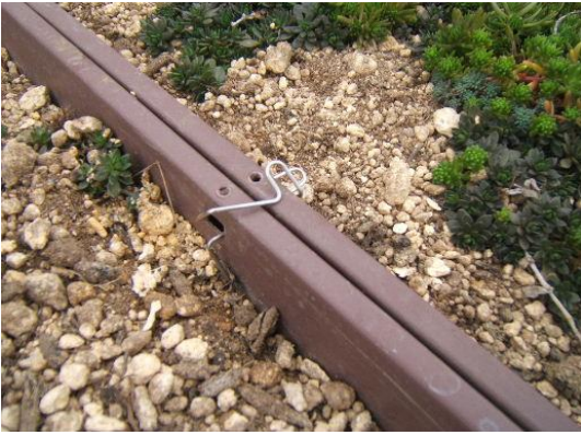
⑦ 連結固定ピンを取り付ける
