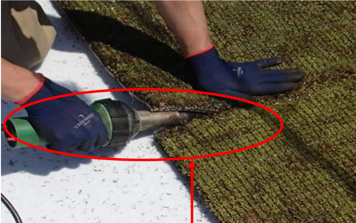
コケマットと排水保護マットの溶着固定作業
