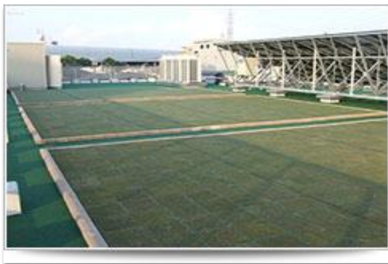
埼玉県川口 市・工場屋上
