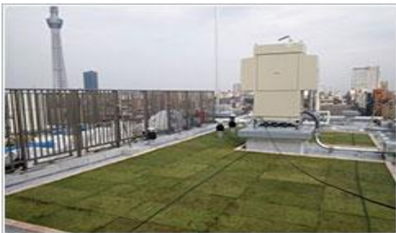
東京都墨田 区・マンショ ン屋上
