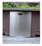
下地に固定された金属板窓にSUSピンを貫通し連結します。
