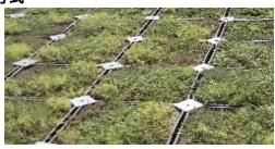
固定ネジを強く締めると、ネジ溝が潰れ、ネジが抜ける。 見た目で発見できず、1個飛散すると、 連鎖飛散につながります。
