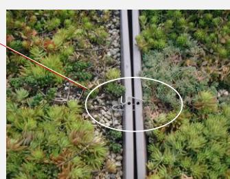
緑化トレー固定は、固定板を下地に接着固定し、両側から緑化トレーを挟み並べ、連結固定ピンでトレーと固定板を刺し通し固定する方式です。風の吹き上げ力を連結固定ピンが受け止め、断線するまで固定する最も安全な固定方法です。
